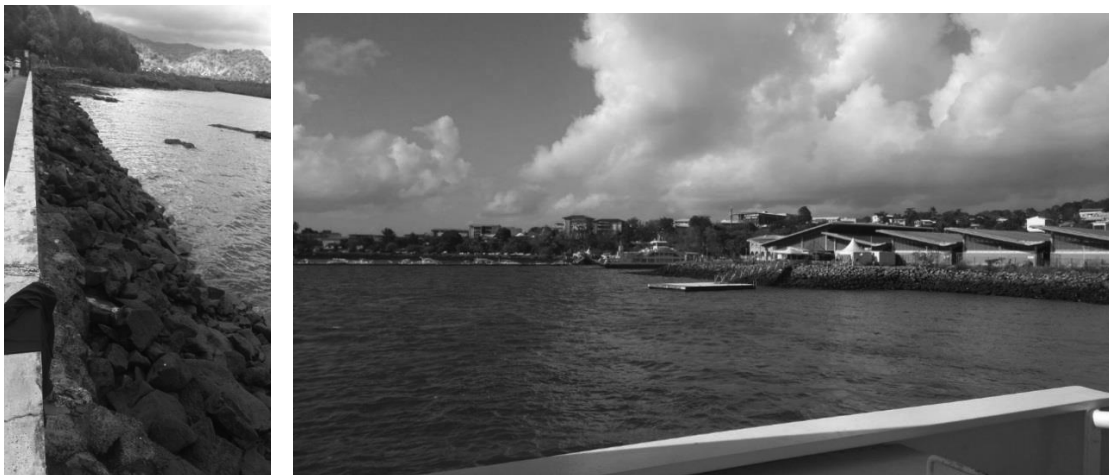
Figure 41 : Photographie des berges existantes
