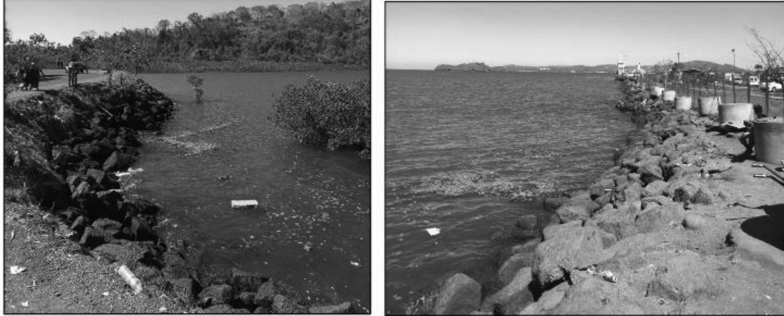
Figure 52 : Cordon protecteur au nord de la zone
