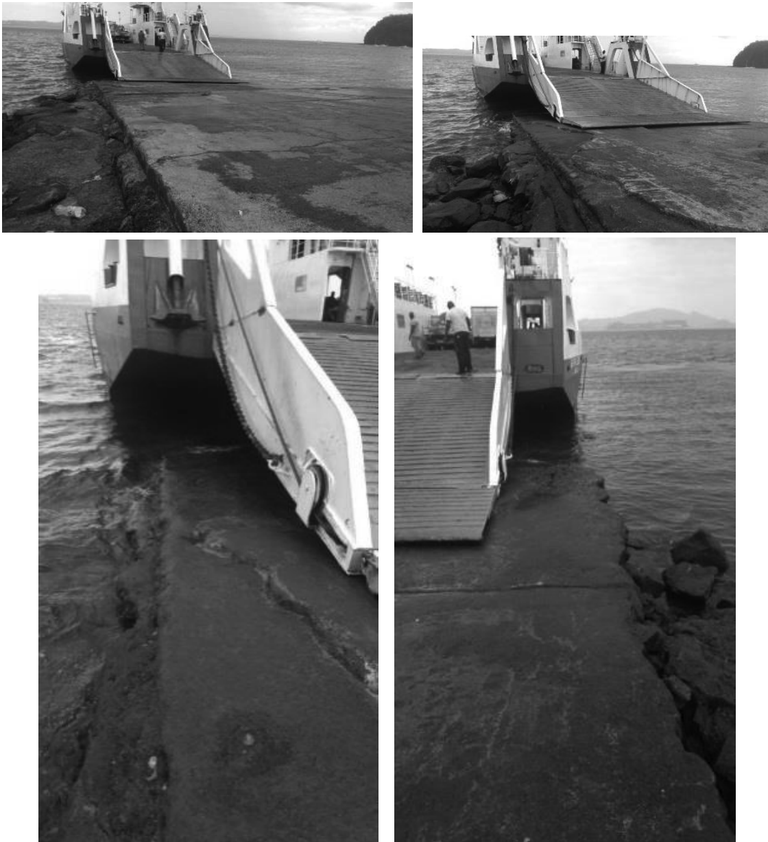
Figure 42 : Photographie de la cale existante (Quai Colas)
