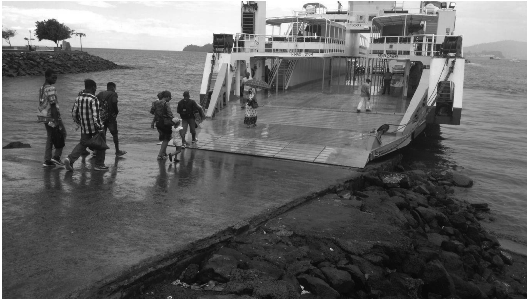
Figure 45 : Photographie du quai des barges
